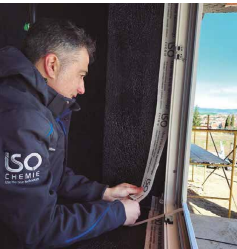
^ Foto: ISO-CHEMIE: Instalación de láminas de hermeticidad ISO-CONNECT
