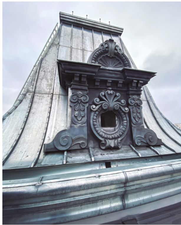
Foto: Xavi Martín Detalle de la restauración de los torreones, previa a su limpieza
