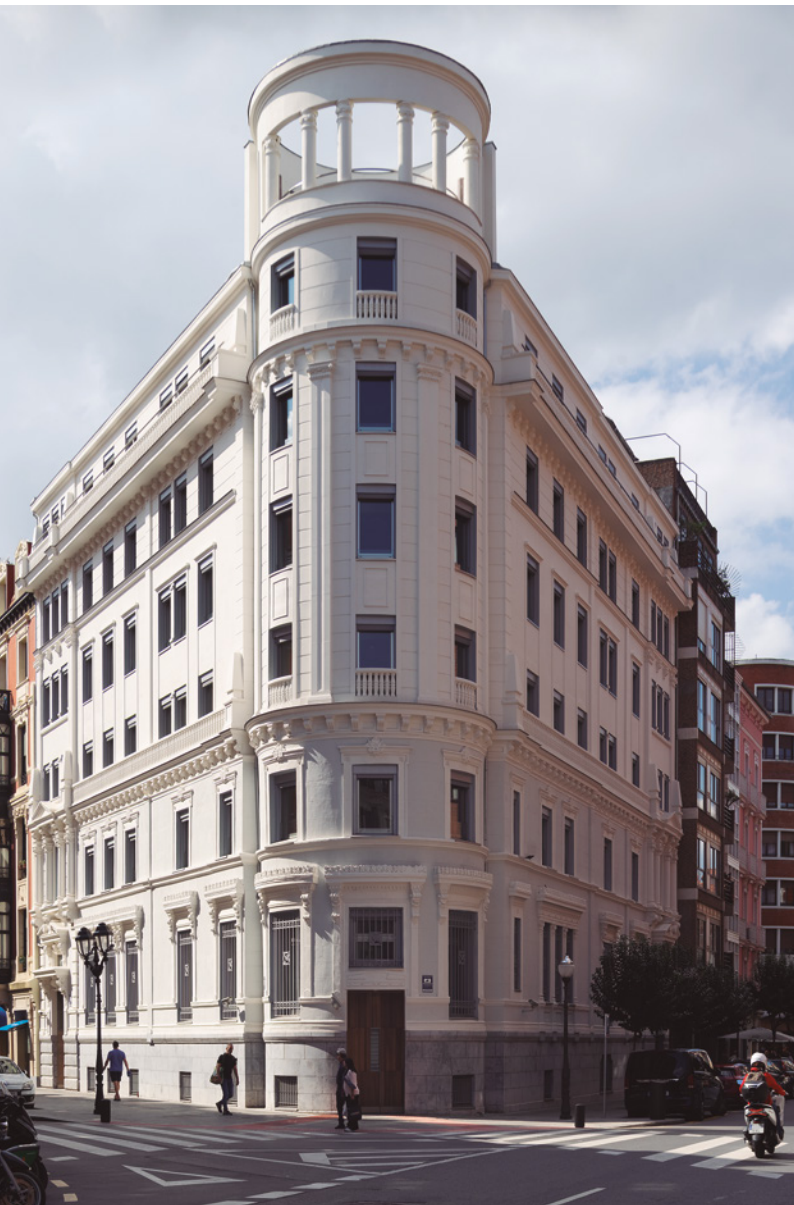
^ Foto: Vista Fachada Exterior
