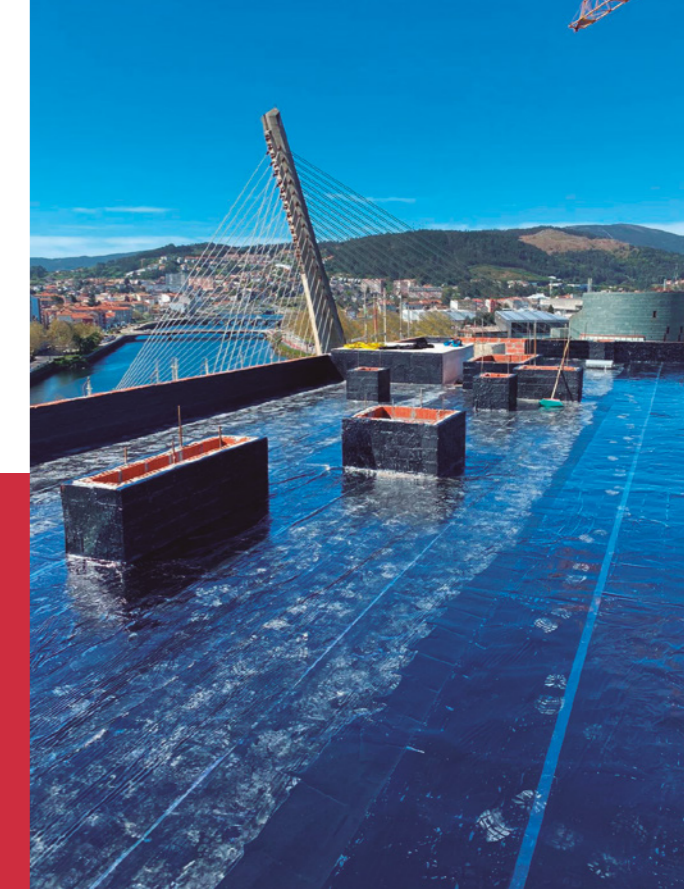
Foto: DRAGADOS. Residencial Novolérez mvc. Pontevedra. 2020.
