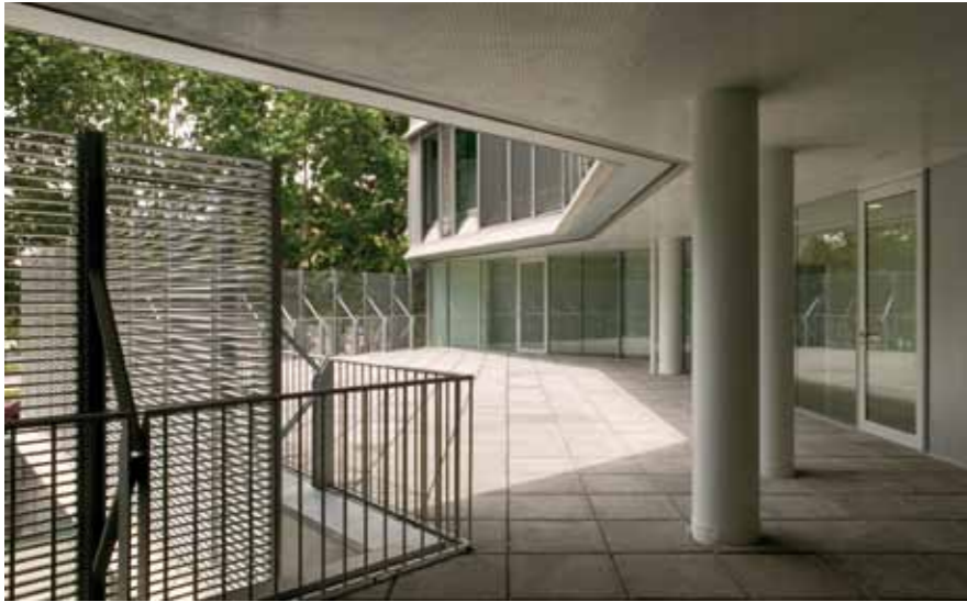
Centro de servicios sociosanitarios del IMAS (Geriatrico) Barcelona (2002-2005). Foto: Clotet, Paricio i Associats
