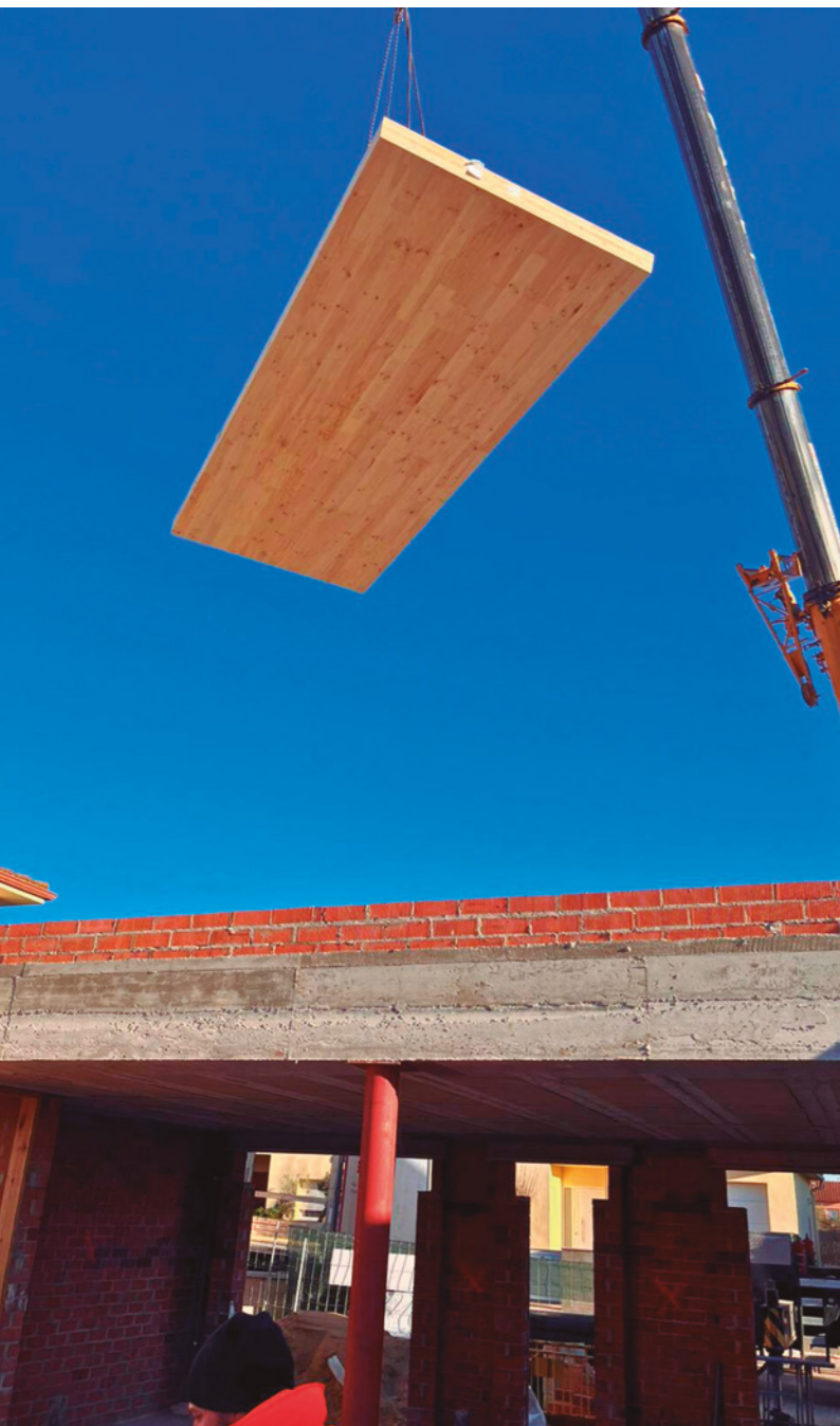
^ Foto: Fusta Framing
