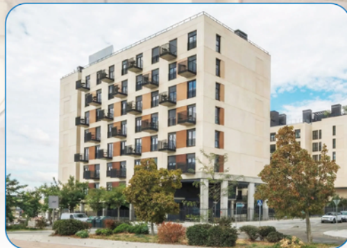
Edificio Cálido Valdebebas
