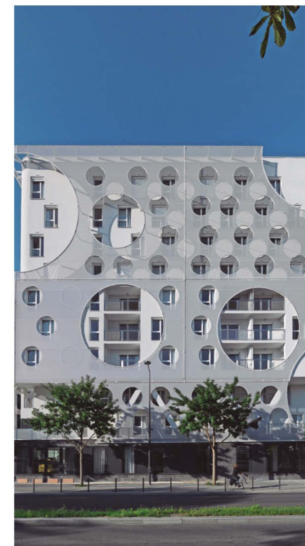
AU FIL DE L'EAU, residencia de la tercera edad residencia de estudiantes y hotel, Ivrry-sur-Seine, Francia
