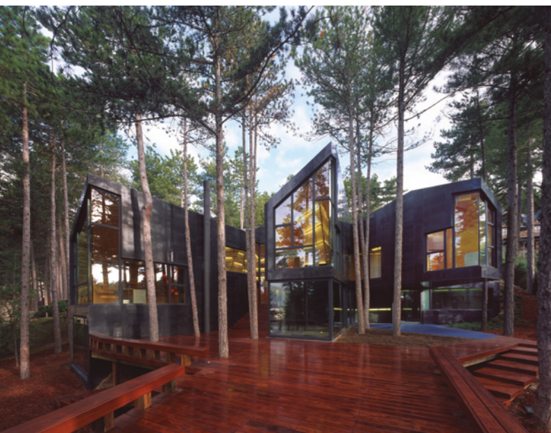
✓ Foto: Casa Levene en El Escorial
