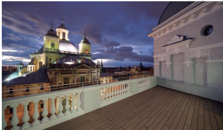
Foto: Rehabilitación del edificio Carrera de San Francisco 15, La Latina, Centro Histórico de Madrid (Santonja / Cubas)
