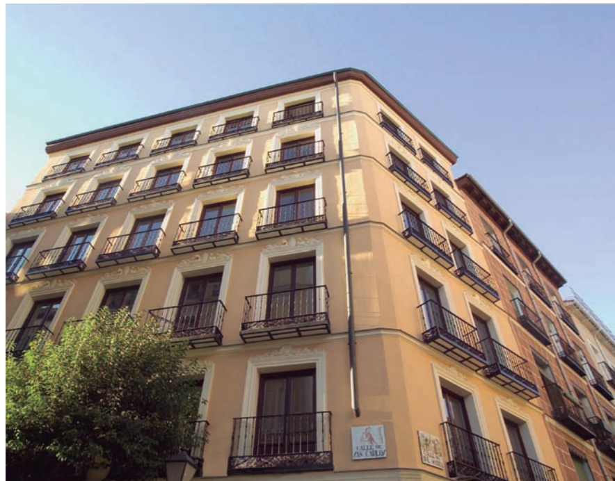
Foto: Rehabilitación del edificio San Carlos 17, Lavapiés, Centro Histórico de Madrid (EMVS)
