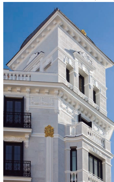
Foto: Rehabilitación del edificio Carrera de San Francisco 15, La Latina, Centro Histórico de Madrid (Santonja / Cubas)
