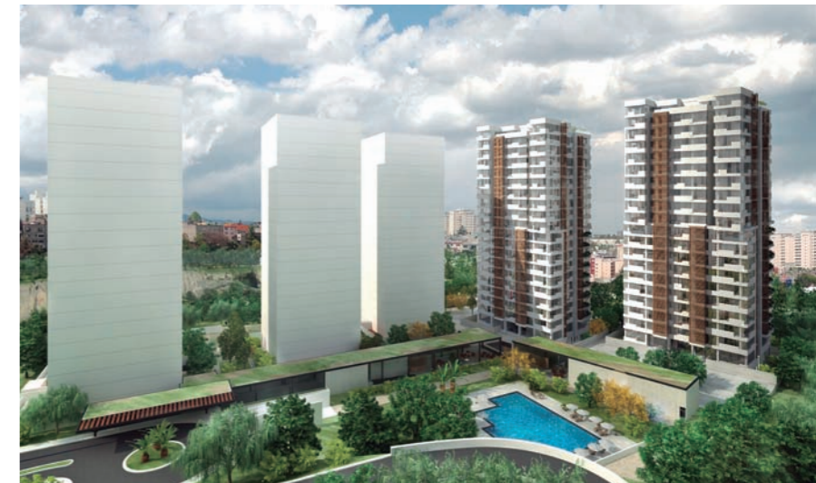
Foto: Residencial Maranta, 208 viviendas. MÉXICO
