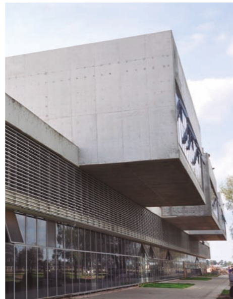
Foto: Hospital Venado Tuerto, Venado Tuerto, en construcción
