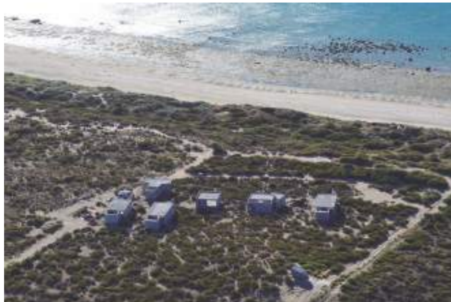
Foto: Casas Lós Médanos, Patagonia, En construcción, 2016
