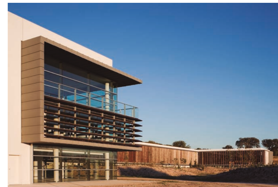
Foto: Centro deportivo San Quintín
