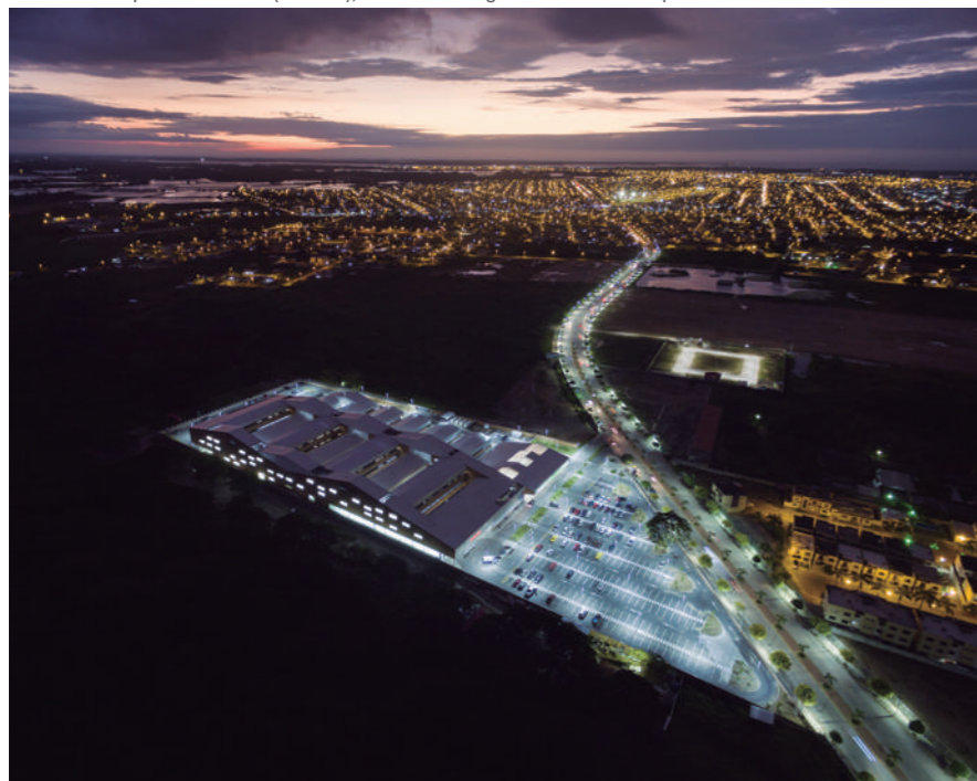
Foto: Fluid Hospital de Machala (Ecuador), de PMMT. Fotógrafo: Sebastián Crespo / Bicubik
