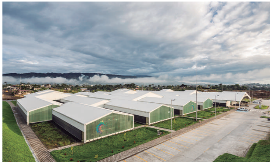
Foto: Hospital Paramétrico de Puyo (Ecuador), de PMMT. Fotógrafo: Sebastián Crespo / Bicubik
