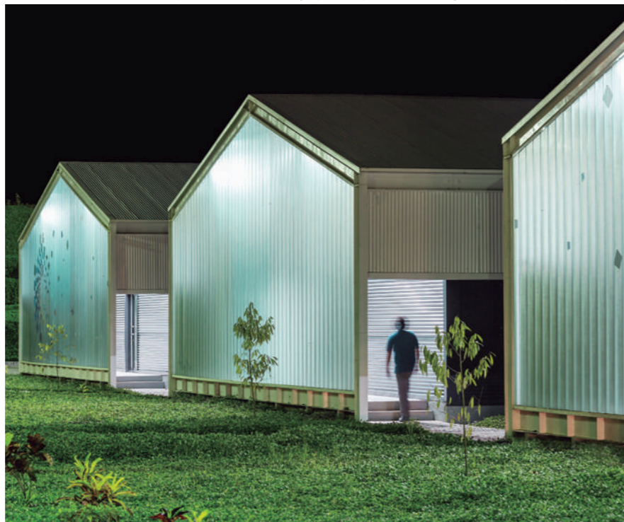
Foto: Hospital Paramétrico de Puyo (Ecuador), de PMMT. Fotógrafo: Sebastián Crespo / Bicubik
