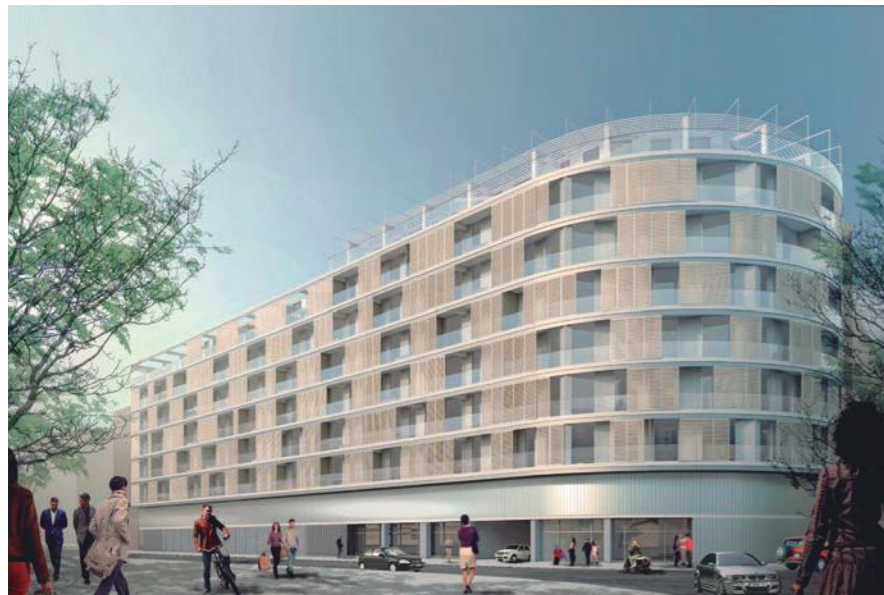
Foto: Rehabilitación Edificio para Viviendas de Alquiler
