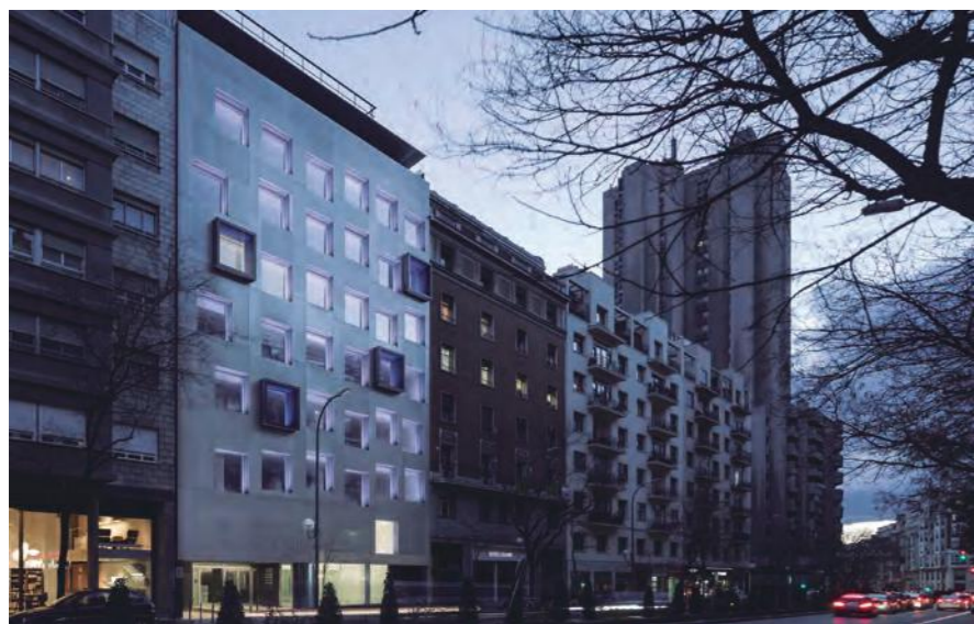
Foto: Edificio O'Donnell 12 Madrid
