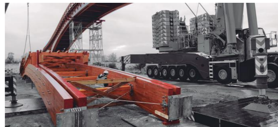
Foto: Inspección de la estructura antes de su izado
