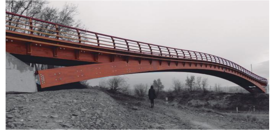
Foto: Puente Anillo Verde, Vitoria. 61 metros de luz
