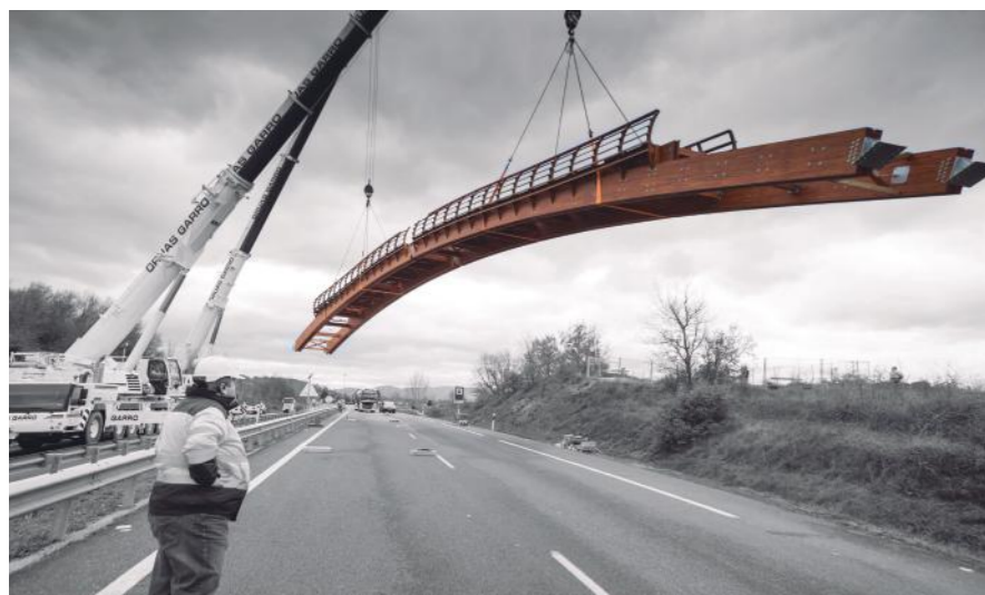
Foto: Momento del lanzamiento del puente de Vitoria
