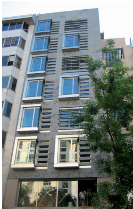
Foto: 14 Viviendas Colectivas, Locales y Garajes en la calle Fuencarral de Madrid
