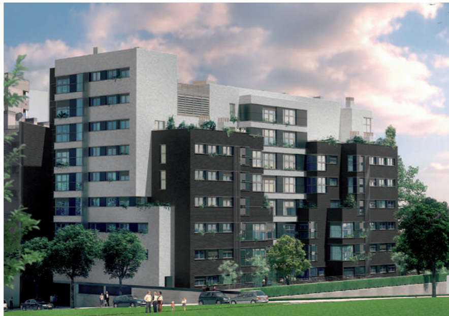
Foto: 52 Viviendas Colectivas VPPB y Garajes en Valdebebas, Madrid
