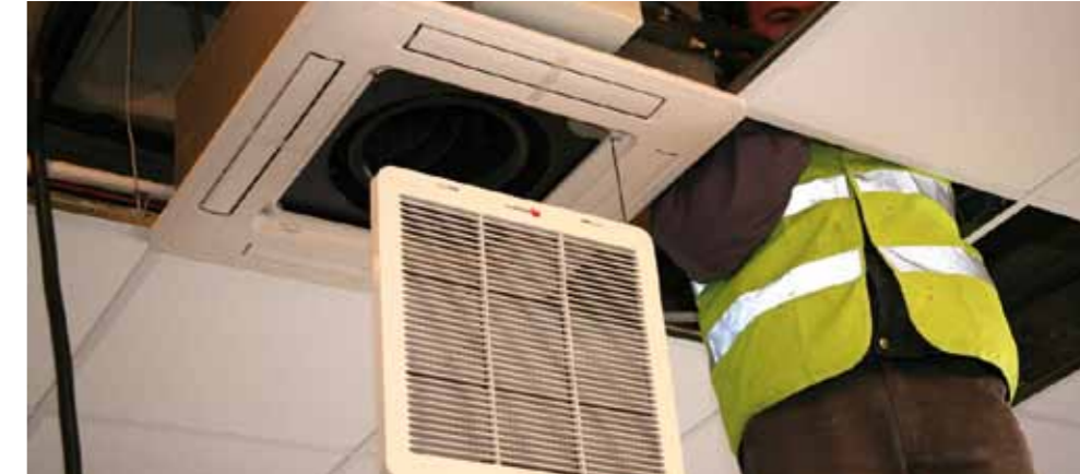
Instalación cassette. Foto: Saunier Duval
