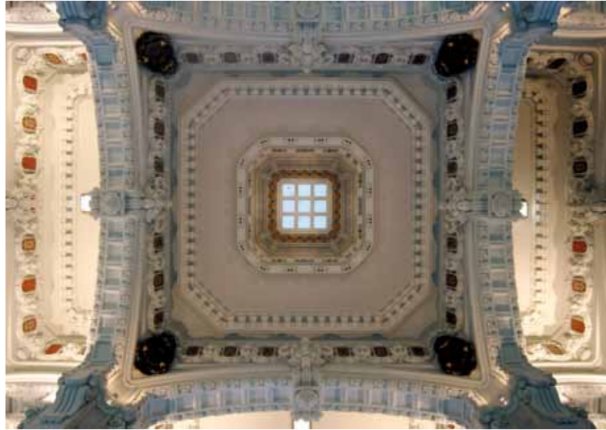
Patio de operaciones. Foto: Arquimática
