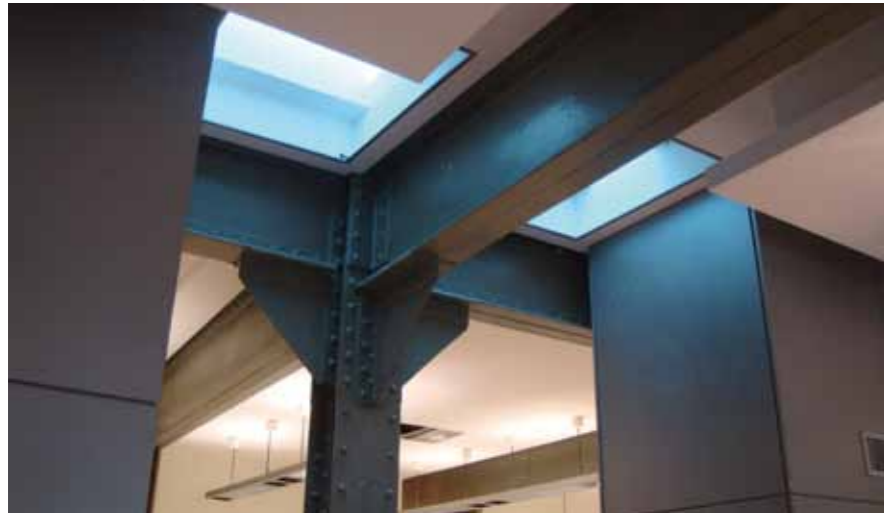
Oficinas. Foto: Arquimática
