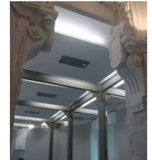
Patio de operaciones. Foto: Arquimática
