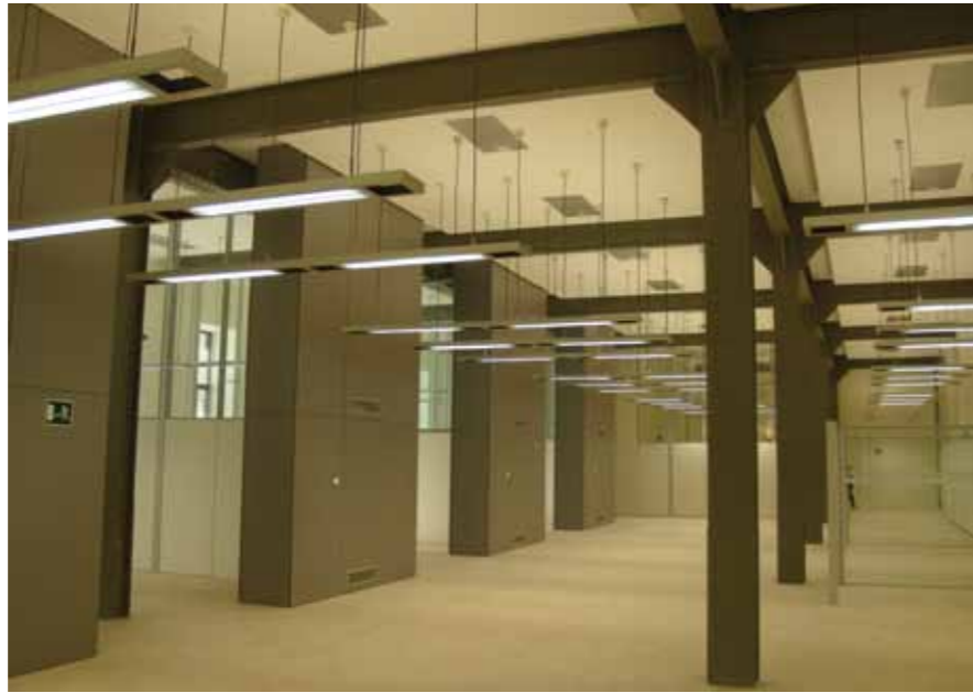
Oficinas. Foto: Arquimática
