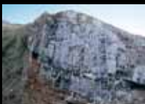
Desmonte entre edificaciones 6.800 m³ Altura 13 m.
