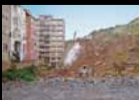
Desmonte entre edificaciones 6.800 m³ Altura 13 m.
