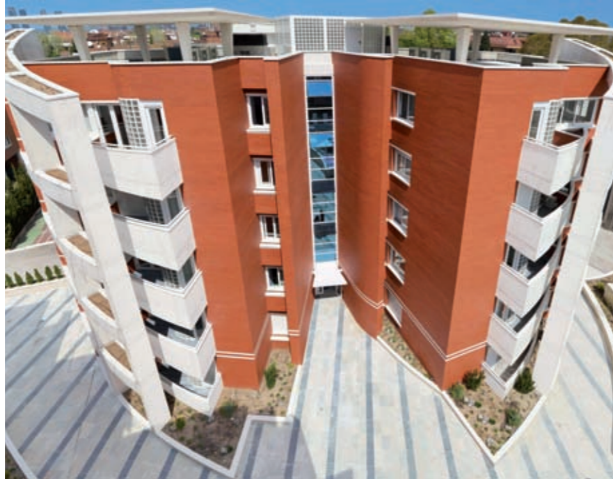
Fotos: Cervera & Pioz Arquitectos
