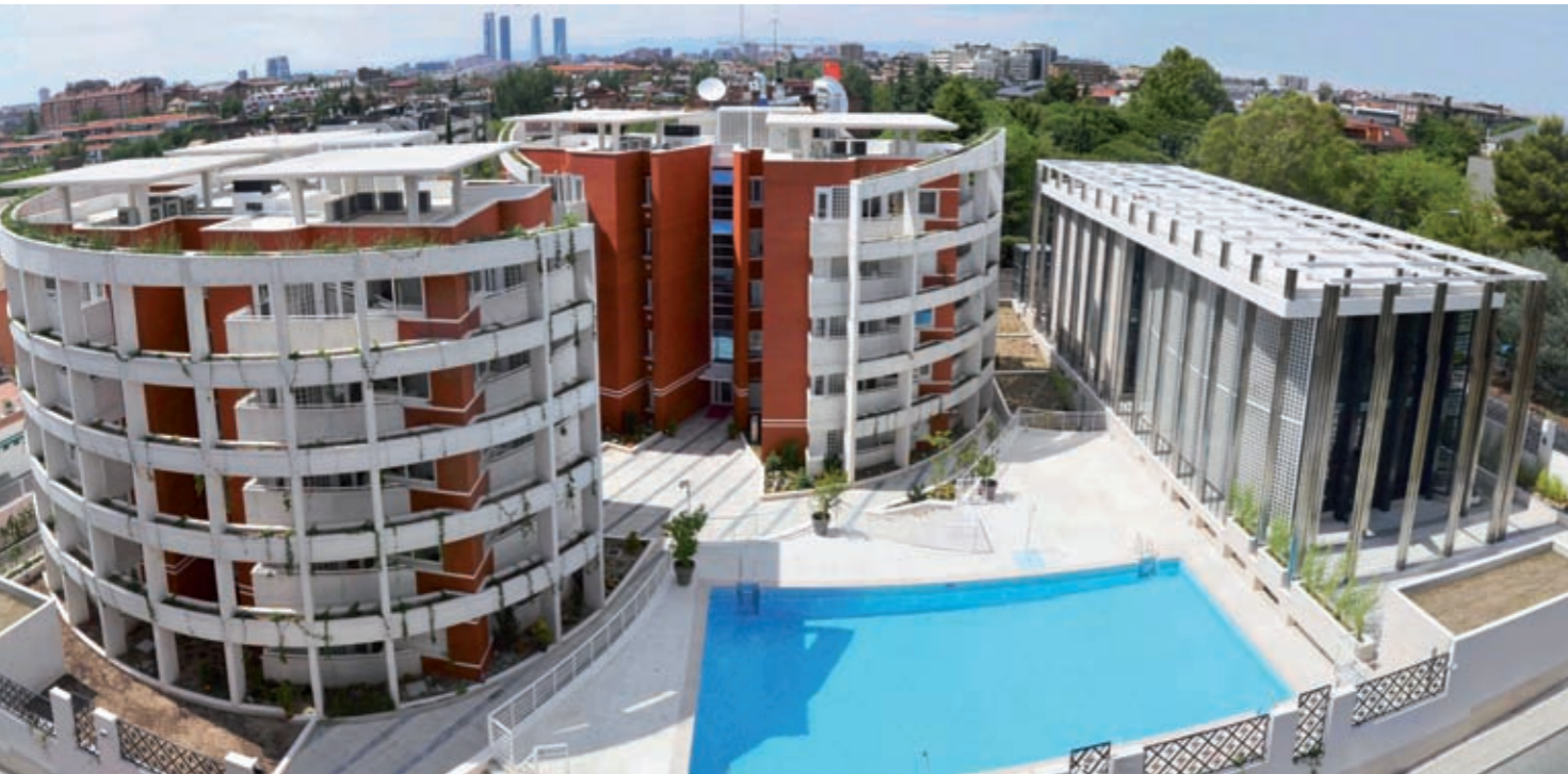
Fotos: Cervera & Pioz Arquitectos
