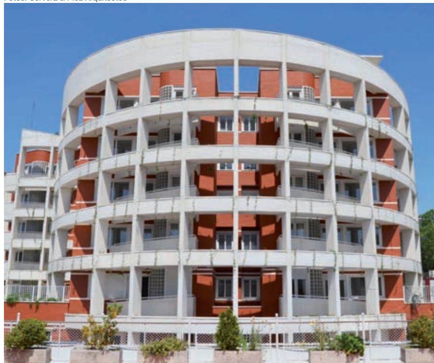
Fotos: Cervera & Pioz Arquitectos
