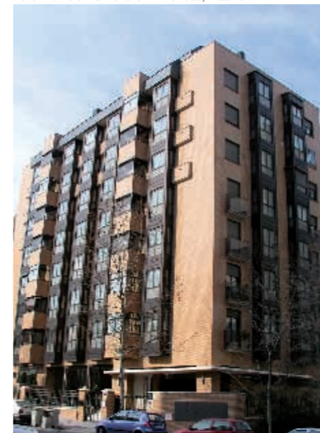
Foto: Edificio Balmoral 32 Viviendas, Madrid
