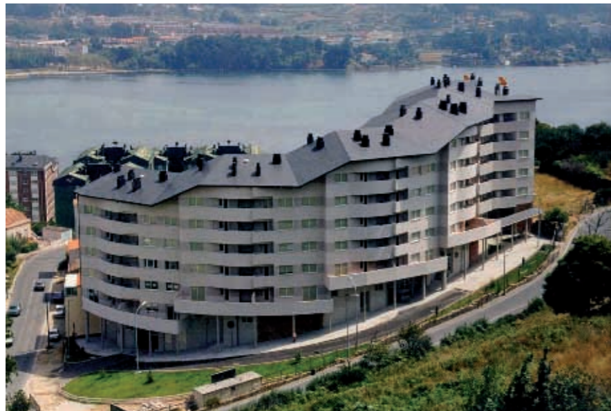
Foto: Mirador de Vilaboa 90 Viviendas, La Coruña
