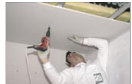
Instalación de placa de yeso sobre aislamiento Fotos: Pladur
