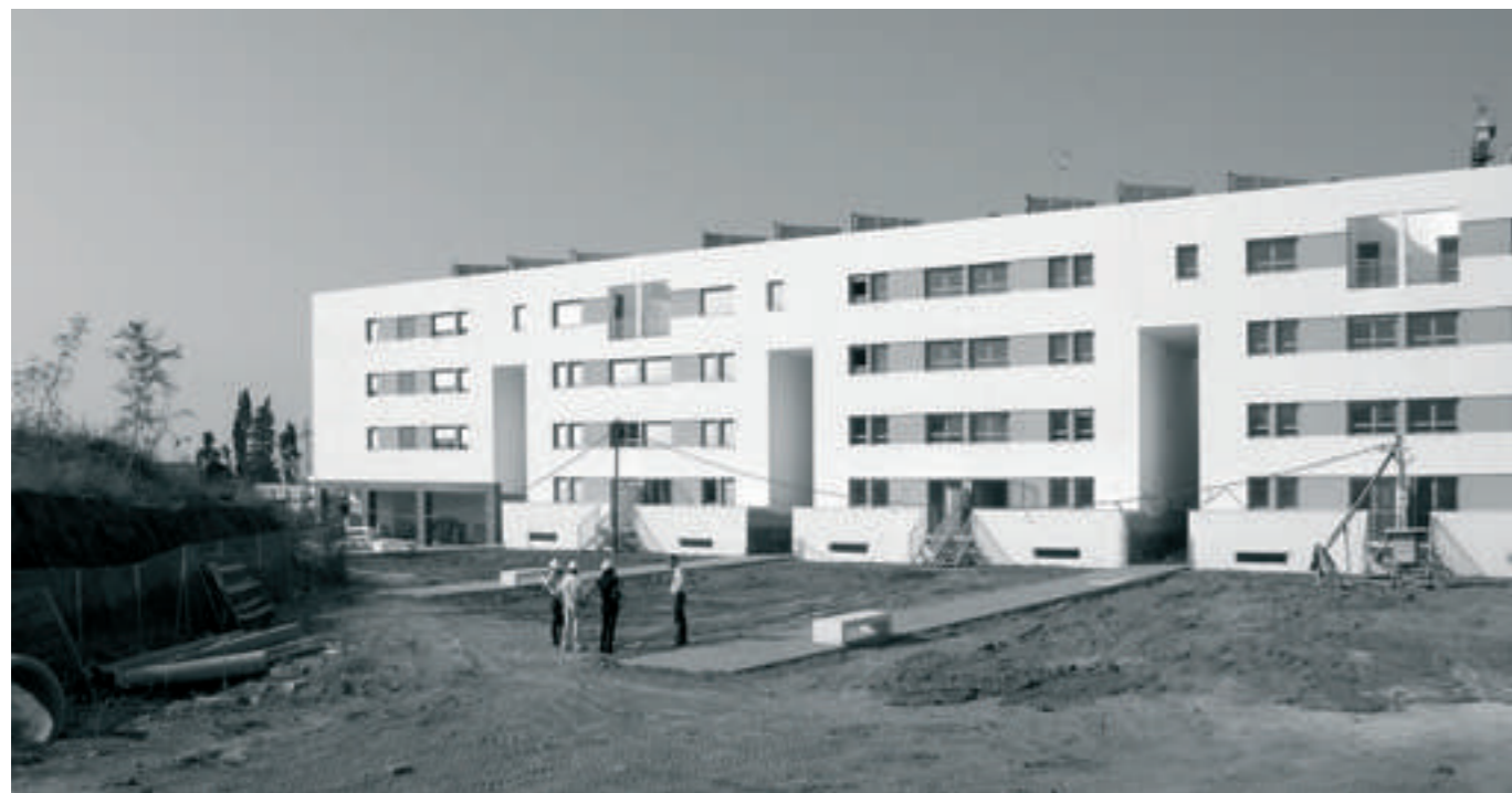
Construcción de las Viviendas en Soliva Este
