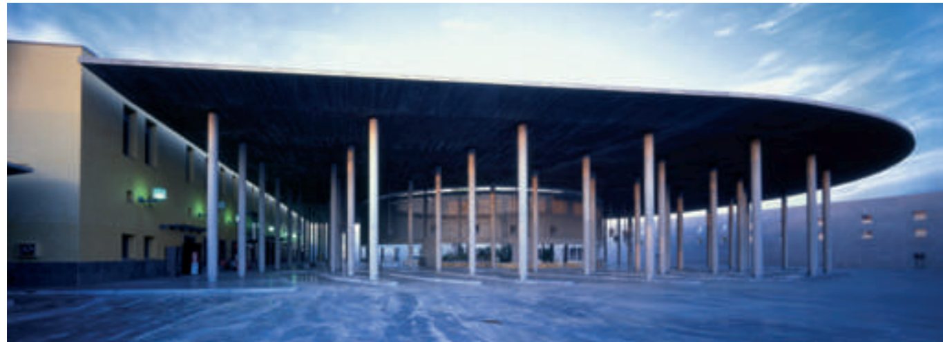
Dársenas de la Estación de Autobuses de Córdoba
