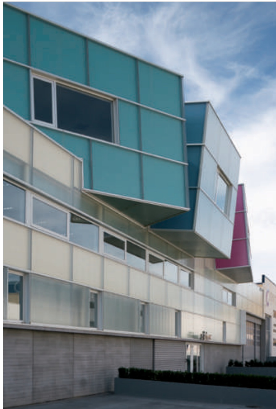
Fachada de la Sede de Tuc Tuc
