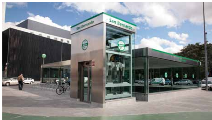
Foto: MP Ascensores
