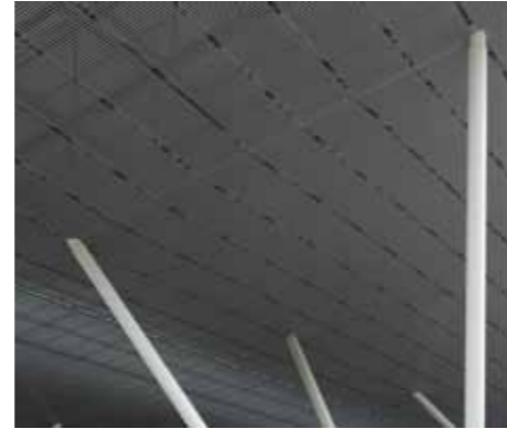
Falso techo procesador. Foto: Alfredo González P.
