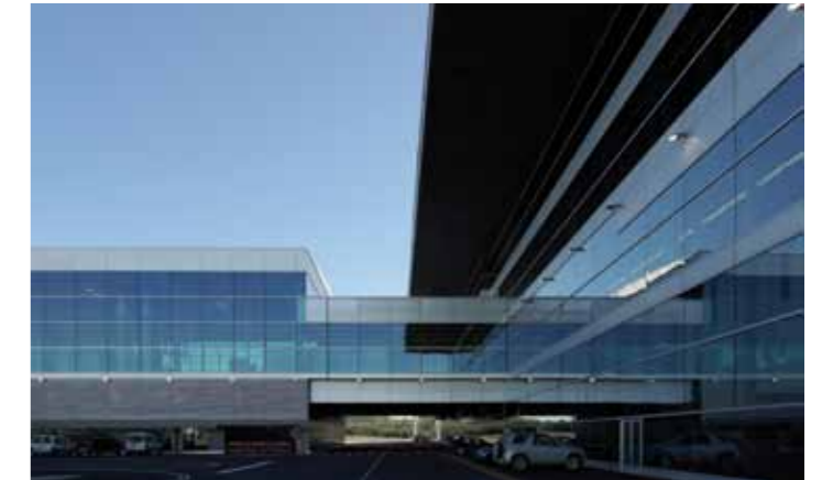
Conexión entre procesador y dique. Foto: Alfredo González P.
