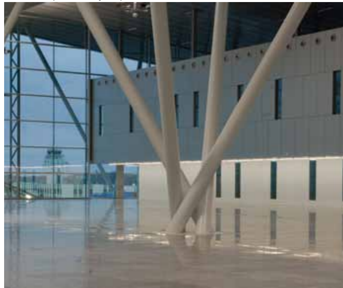
Vestíbulo de procesador y bloque técnico. Foto: Alfredo González P.
