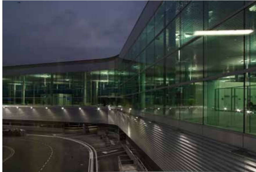
Vista nocturna del dique desde prepasarela. Foto: Alfredo González P.
