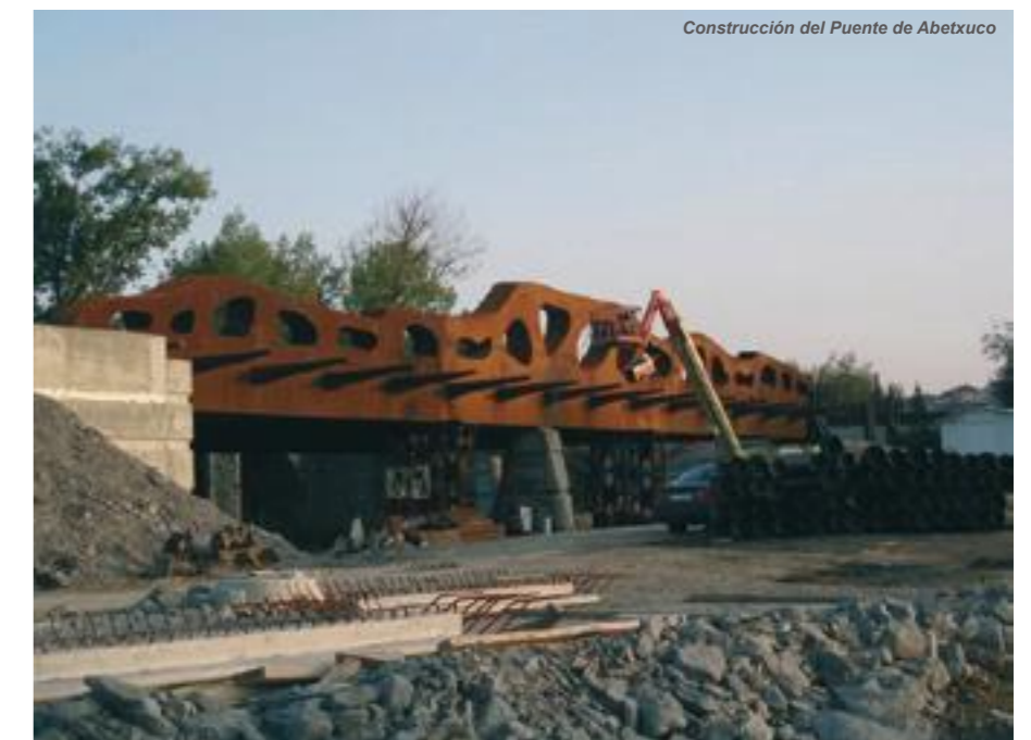
Construcción del Puente de Abetxu
